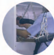
Inside of Refrigerator 冷蔵庫内ロー付け
