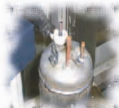
Air Compressor Part コンプレッサ部品ロー付け
